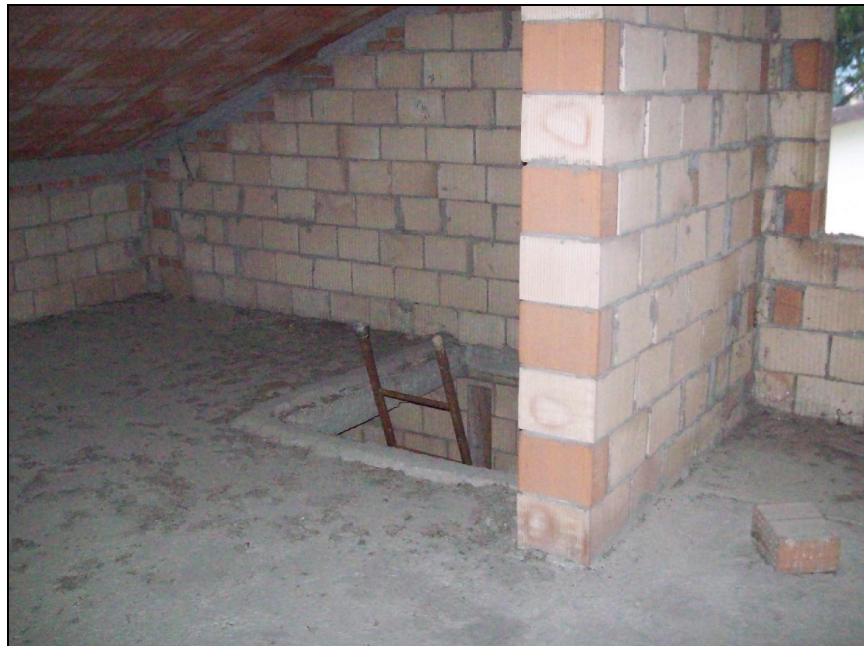
Foto 17: sbarco scala piano sottotetto
