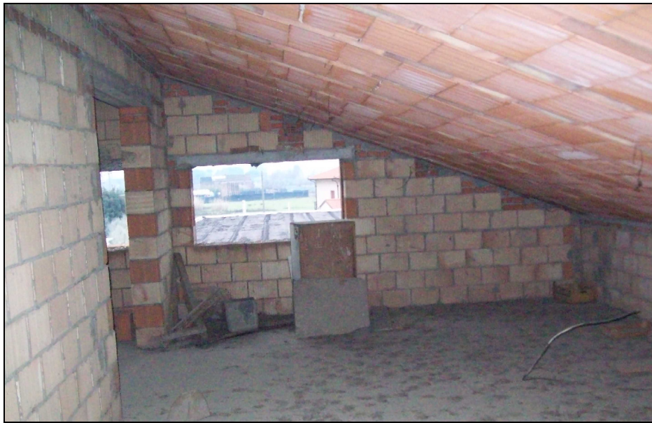
Foto 19: vista piano sottotetto
