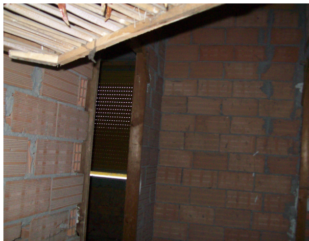
Foto 14: la porta si trova in posizione diversa rispetto allo stato di progetto
