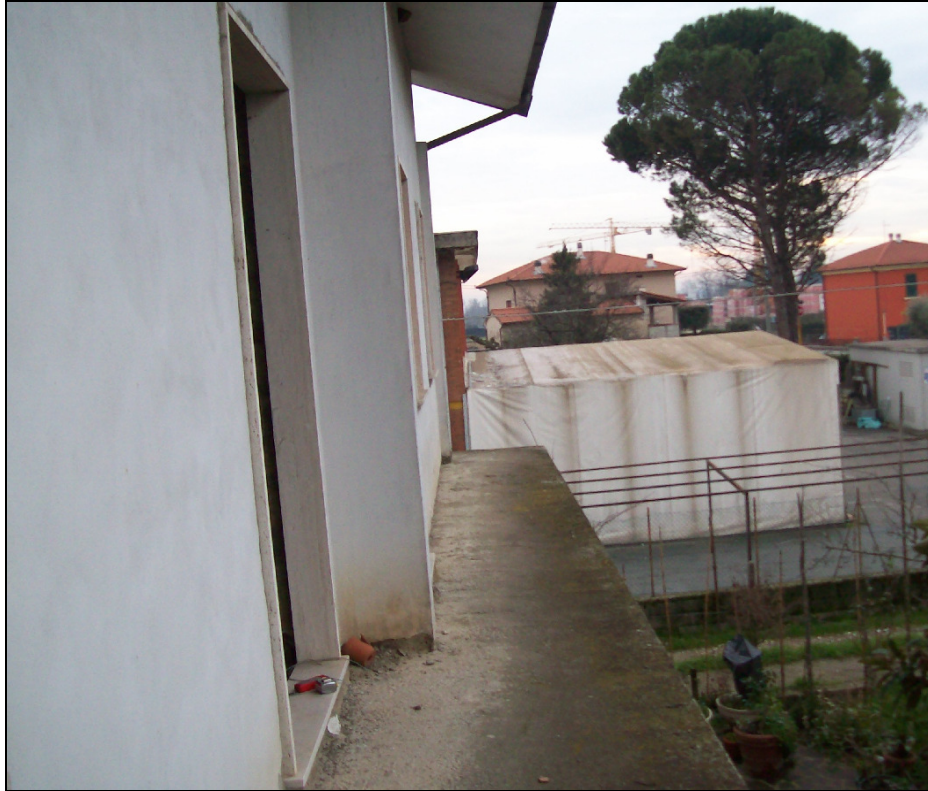
Foto 9: balcone prospetto Ovest
