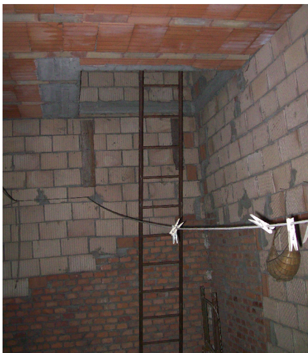
Foto 16: botola di accesso al piano sottotetto
