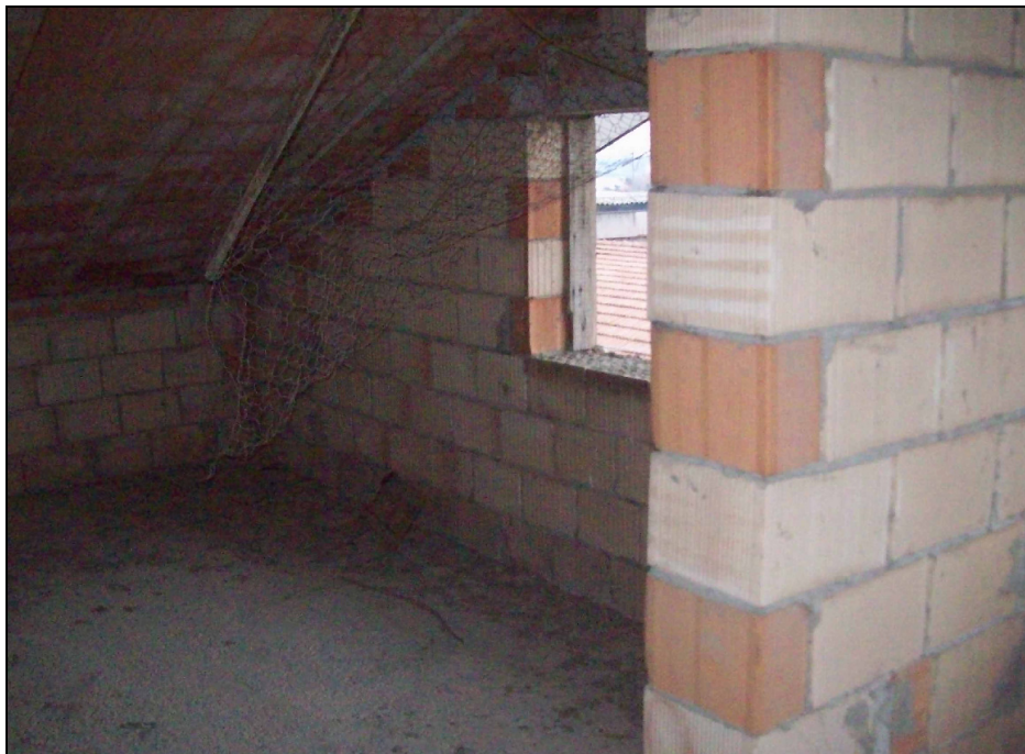
Foto 20: vista piano sottotetto
