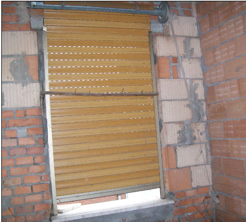
Foto 10: dettaglio infissi esistenti
