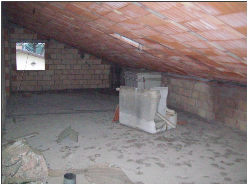
Foto 18: vista piano sottotetto
