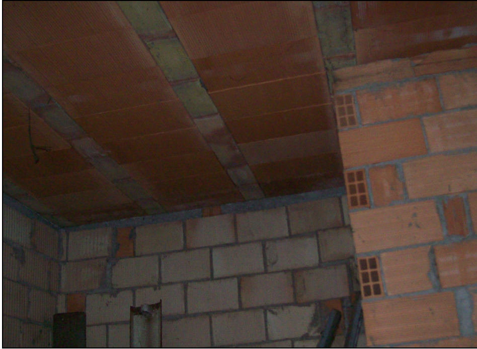
Foto 11: dettaglio solaio tipo Bausta (solaio sottotetto)
