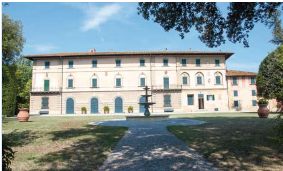
La facciata e il giardino della villa “Poggi-Banchieri” di Castelmartini - Foto Alex Larciano © -
